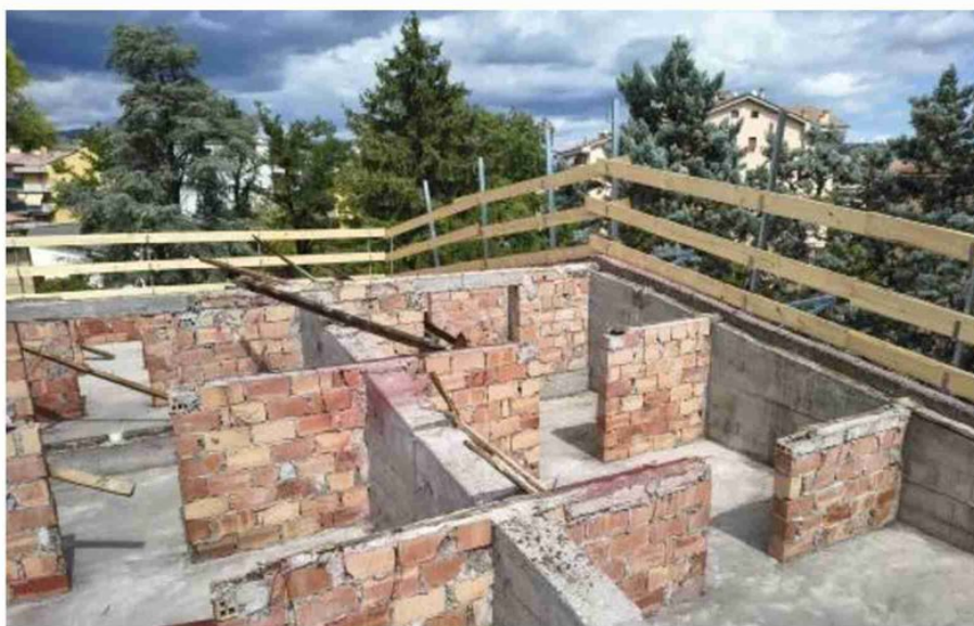
Dopo la bonifica Il tetto dell'ex cinema teatro ripulito dall'amianto
